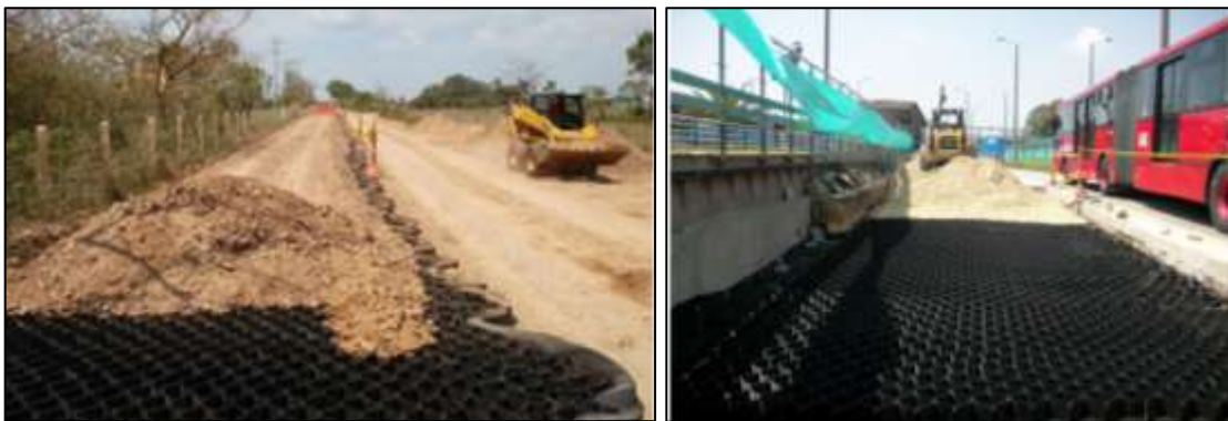
Imagen 2. (a) Refuerzo en vías Campo Petrolero Rancho Hermoso, Casanare, y (b) Estabilización de suelos Transmilenio Avenida Américas Bogotá D.C. Fuente: PAVCO, 2012.
