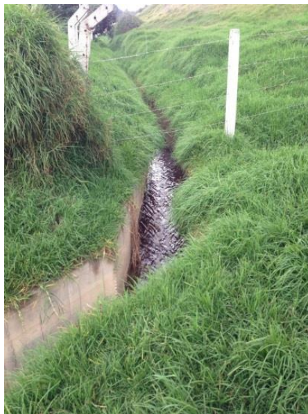
Ilustración 5. Canal de transporte de lixiviado de la Planta de Tratamiento de Lixiviado (PTL) al río Tunjuelo.
