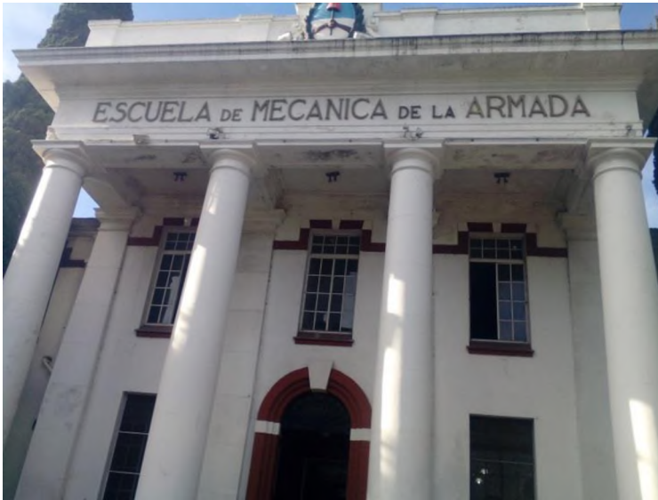
Fachada principal de la ex ESMA
