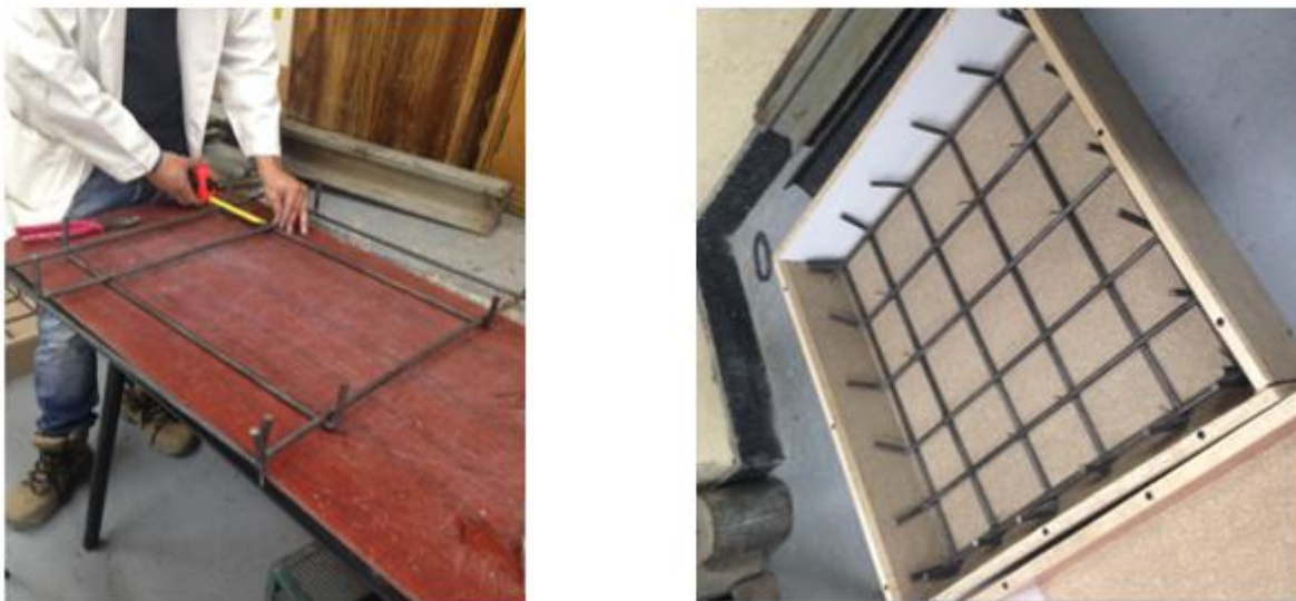
Figura 26. Armado y formaleta para losas.
