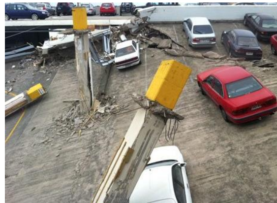
Figura 6. Falla por punzonamiento (Reidmiddleton)
