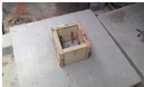
Figura 36. Formaleta para columna.
