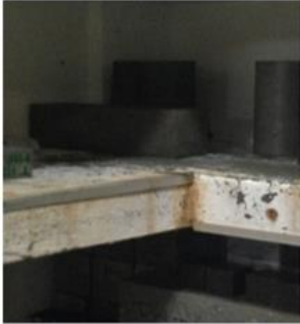
Figura 31. Vigas y cilindros concreto simple
