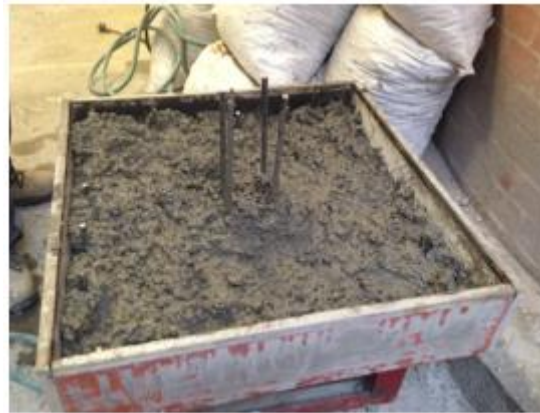
Figura 33. Colocación del concreto losa # 4.
