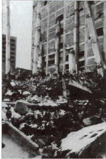
Figura 3. Falla por punzonamiento (Murillo, 2004)
