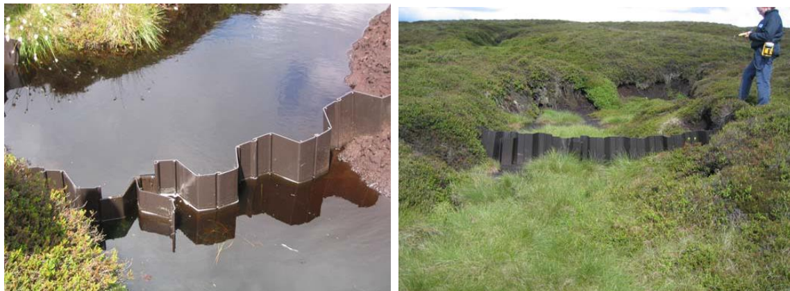
Figura 5. Presa de pilote plástico ubicada en un drenaje de turbera alpina (izquierda). Presa de pilote plástico con vegetación productora de turba, desarrollándose en el drenaje (derecha). Tomado de Evans et al. (2005).
