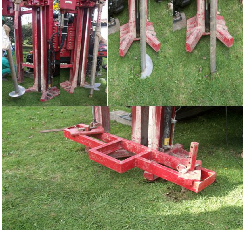
Figura 137. Anclaje del equipo.
