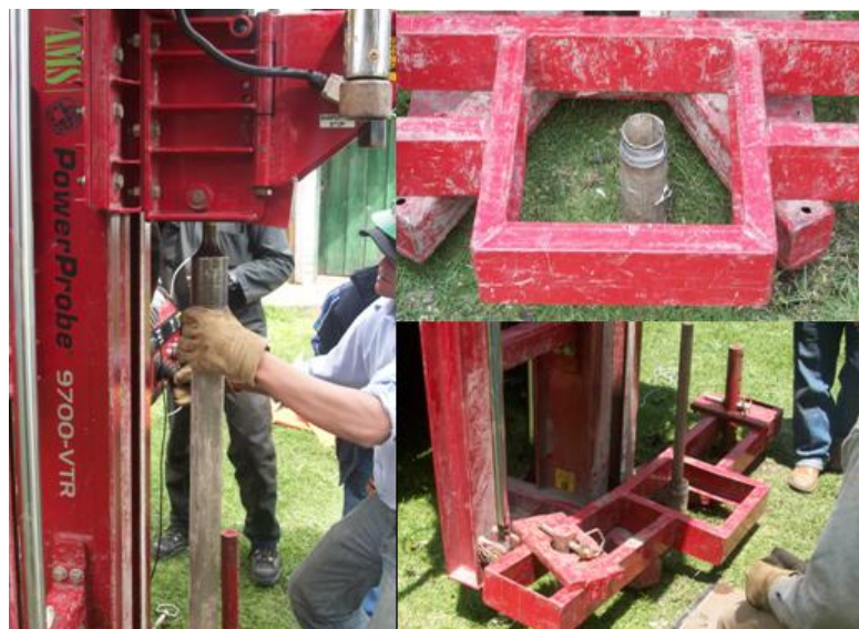
Figura 30. Encamisado de la perforación.
