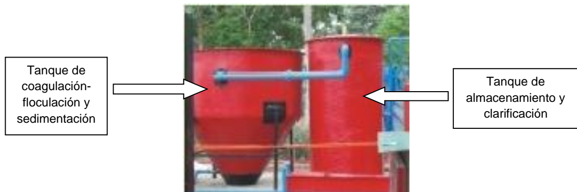
Gráfico 14. Planta de tratamiento de aguas industriales Electromecánica
