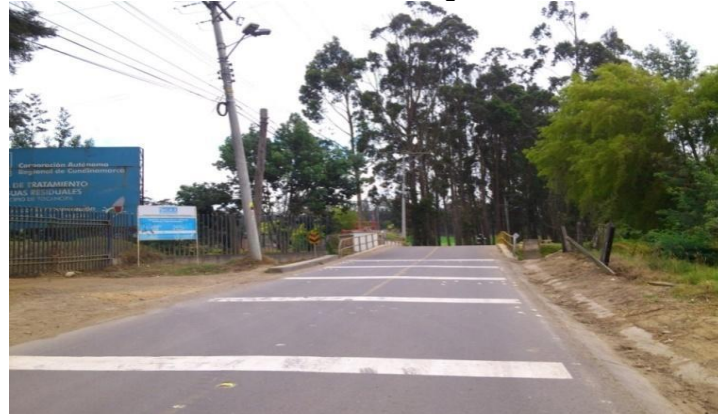
Registro fotográfico 41. Puente vehicular sobre el río Bogotá vereda la Fuente
