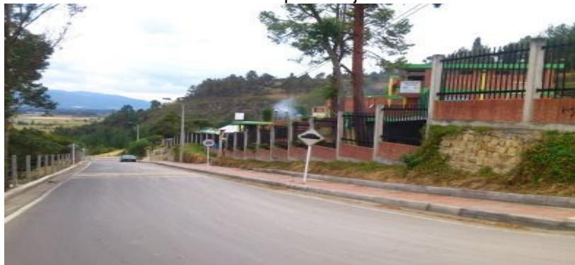
Registro fotográfico 25. Vía sector Buenos Aires parte baja
