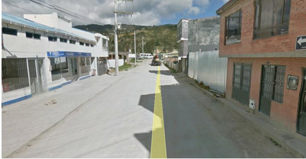
Registro fotográfico 4. Calle 13 casco urbano
