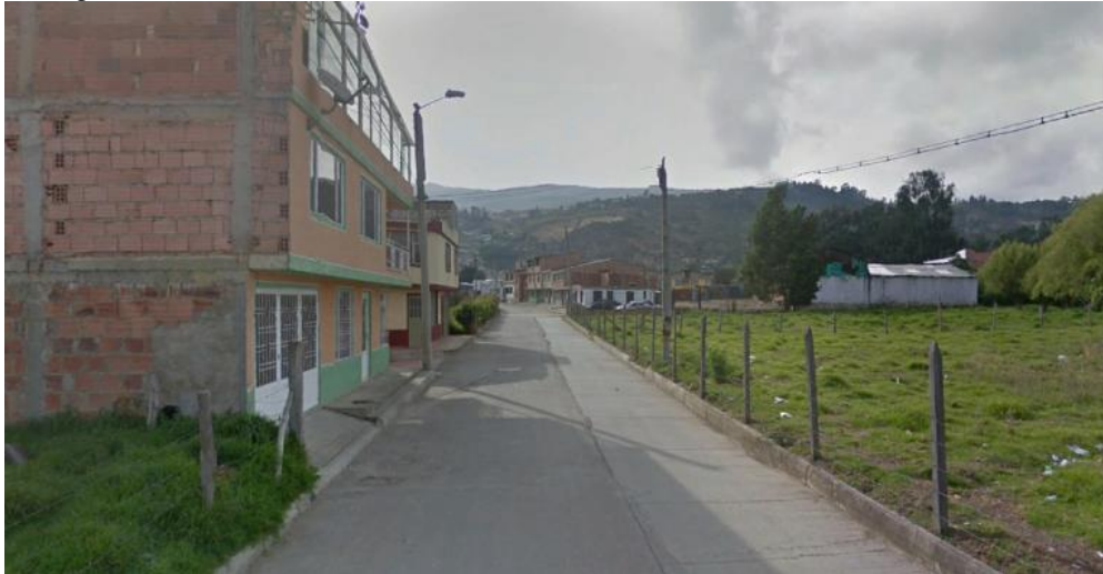
Registro fotográfico 5. Calle 16 casco urbano
