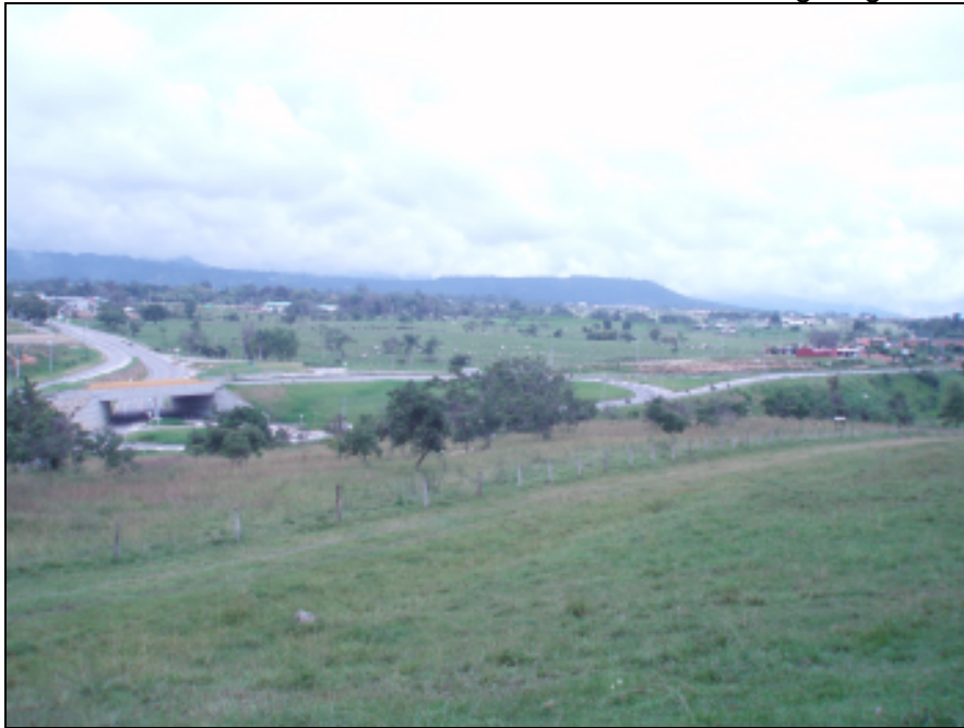
IMAGEN No. 3. Panorámica de la Intersección de Cucharal. Inicio de la Variante de Fusagasugá.
