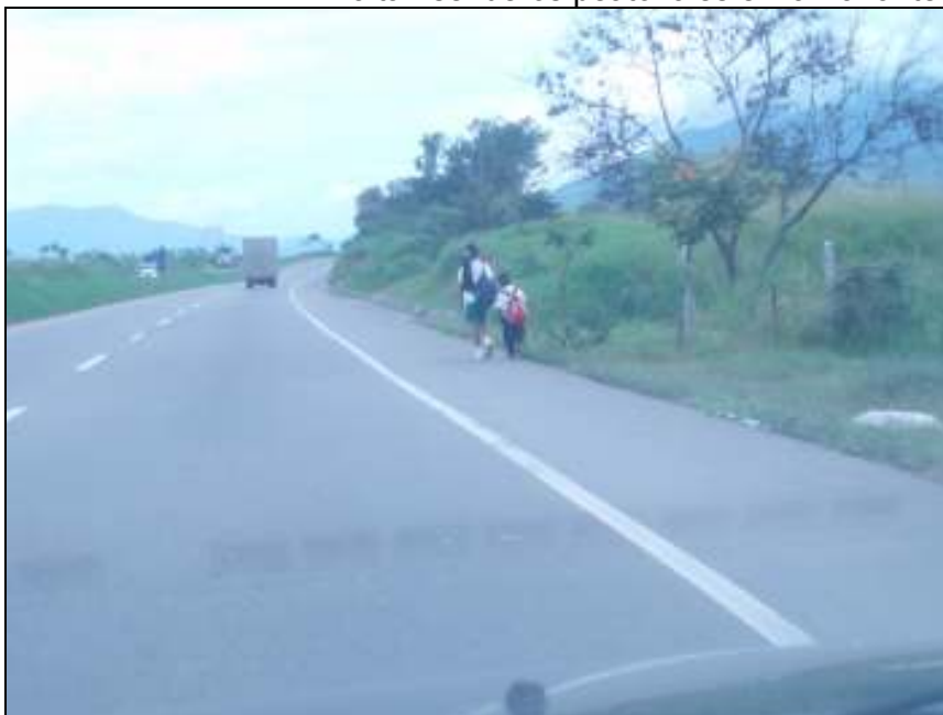
IMAGEN No. 13 Tránsito Peatonal sobre la Berma. Faltan senderos peatonales en la Variante
