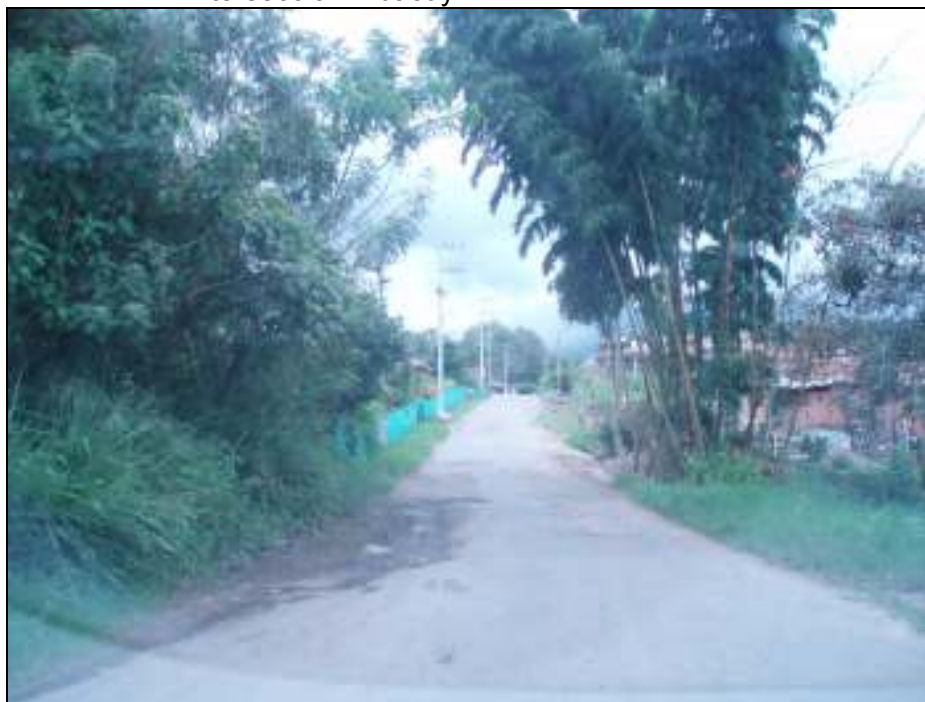
IMAGEN No. 14 Panorámica del estado del Tramo Avenida de las Palmas a la Intersección Tibacuy.
