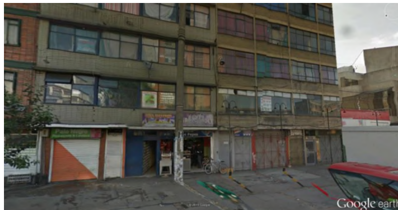
Imagen 1 Zona en Detrimiento
