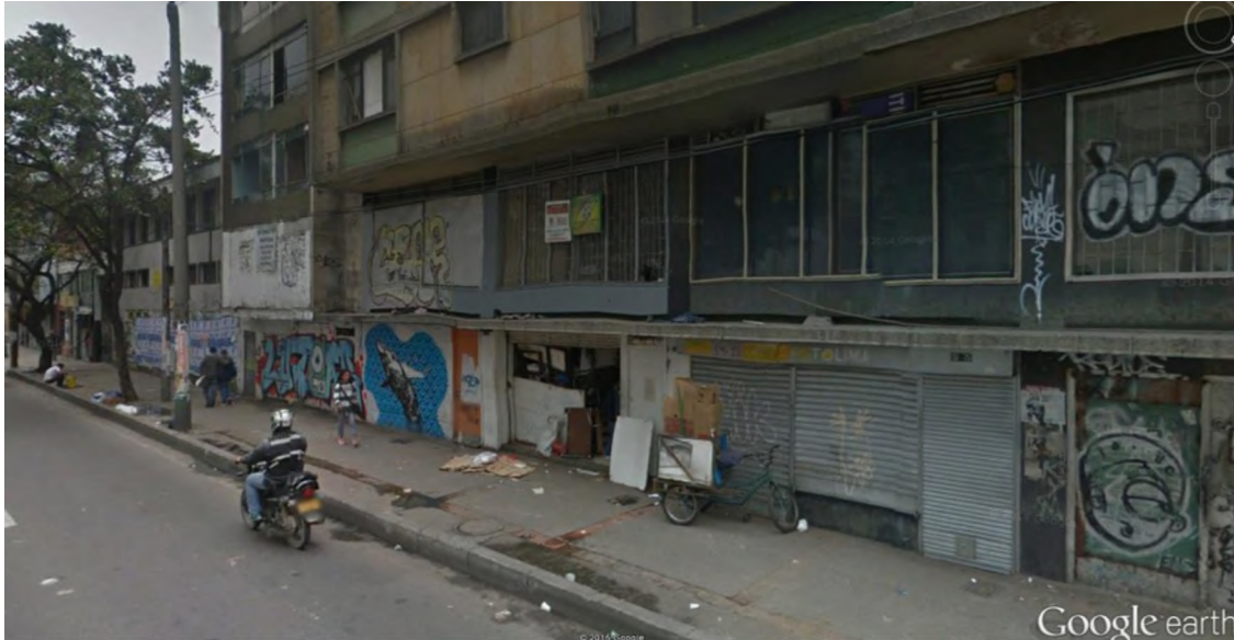
Imagen 2 Zona en Detrimiento
