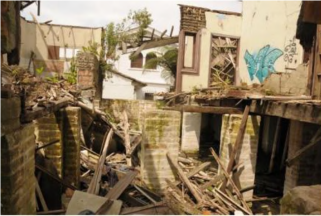
Imagen 7. Vivienda de interés social en ruinas en el barrio Versailles 14
