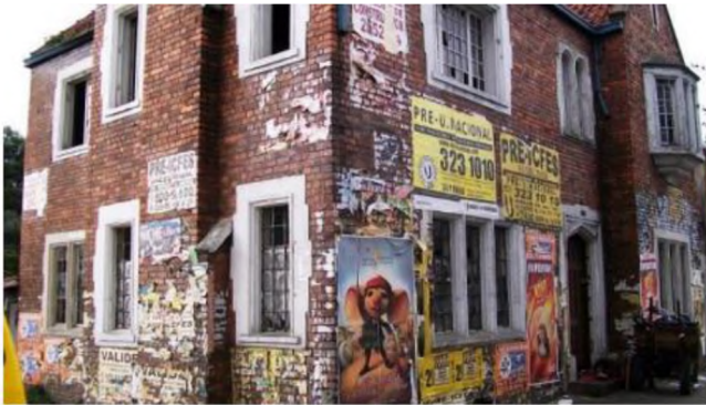
Imagen 8. Vivienda de interés cultural abandonada 15
