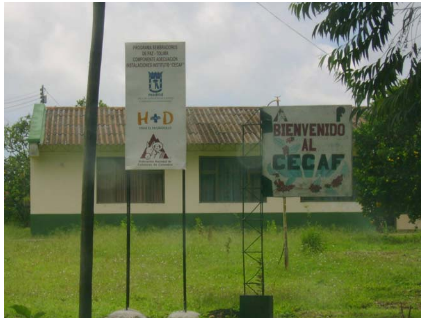
Figura 3. Instalaciones del CECAF
