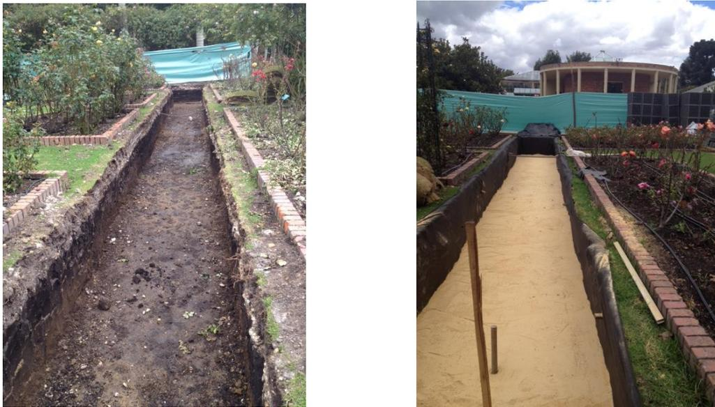
**Figura: 2 Proceso constructivo de los SUDS**
