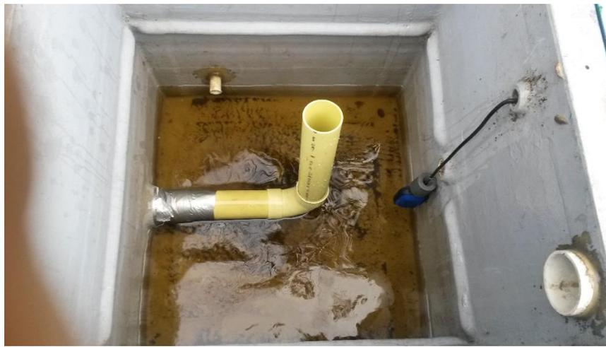
**Figura 5: Sistema implementado tanque caja de inspección.**
