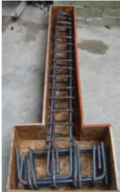
Figura 30. Formaleta y armado de vigas en voladizo.
