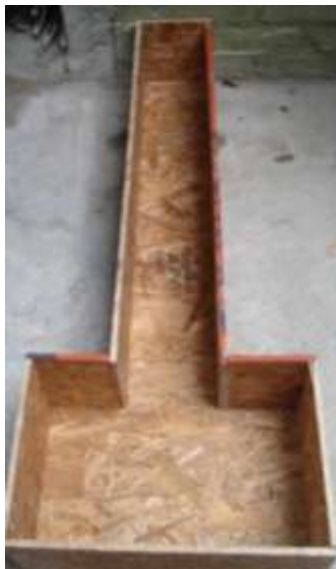
Figura 29. Formaleta de vigas en voladizo
