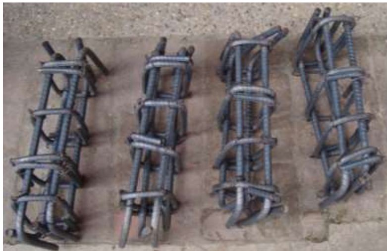
Figura 27. Armado del empotramiento de las vigas.
