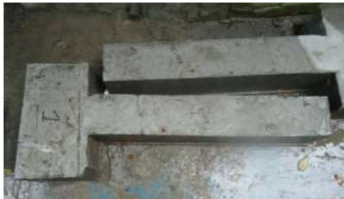
Figura 33. Vigas en voladizo húmedas.
