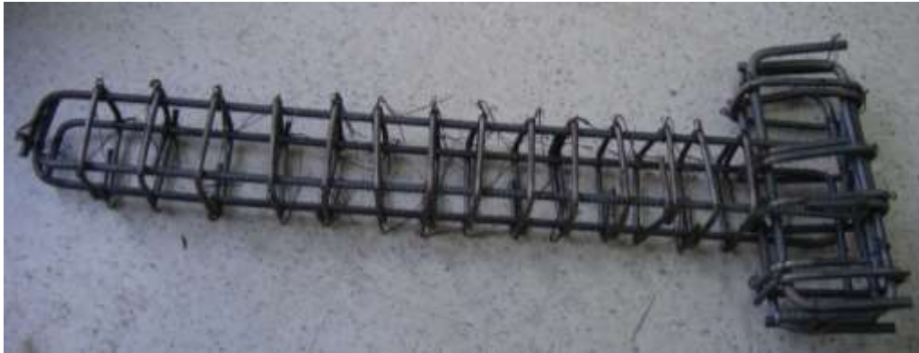
Figura 28. Armado completo de las vigas en voladizo.
