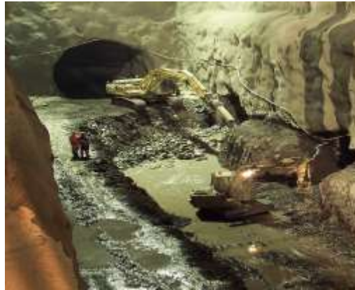
Figura 3. Sika S.A Informaciones Técnicas, Concreto reforzado
