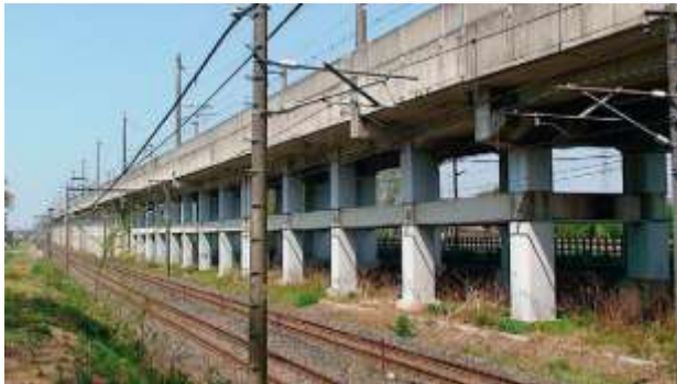
(a) Puente ferroviario con estructura tipo pórtico
