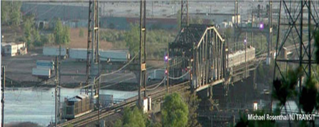
Fig.5 Fotografía del Portal Bridge
