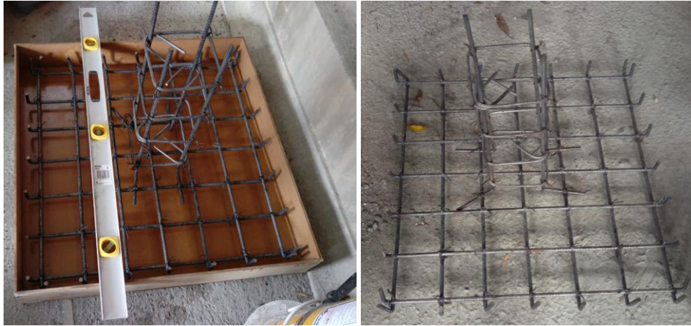
Figura 39. Armado y formaleta para losas.
