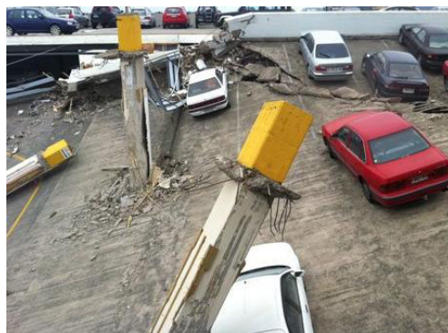
Figura 11. Falla por punzonamiento (Reidmiddleton, 2013).
