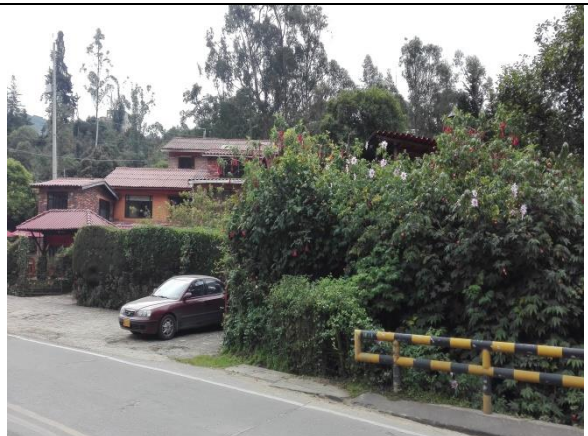
Puente Via Bogotá – La Calera, restaurante en el constado oriental
