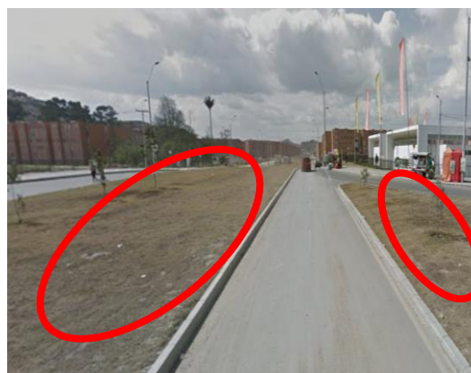
Figura 3.24. Andenes sin pavimentar en acceso a Hogares Soacha
