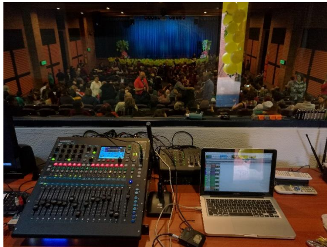
Cabina de control – Fotografía tomada por el autor
