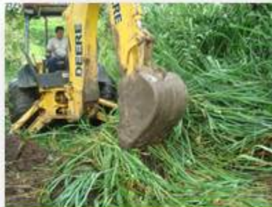
Descapote: Eliminar la capa vegetal
