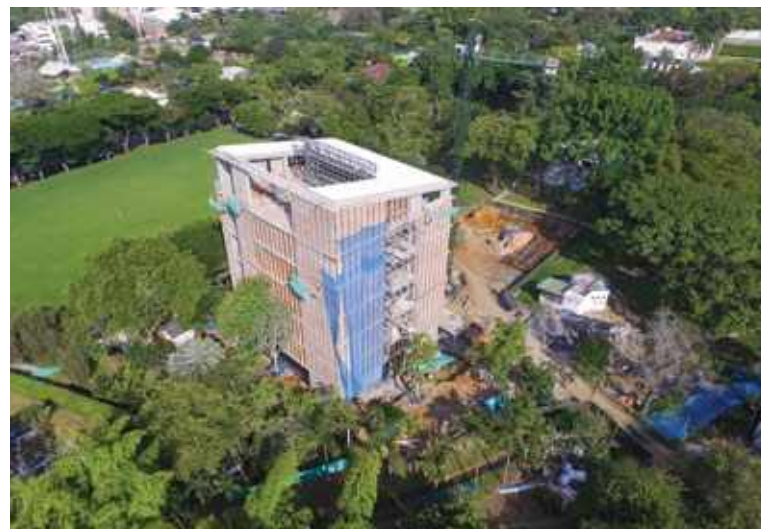
→ Cali Design Factory, nuevo edificio de Javeriana Cali donde estará el laboratorio de innovación y emprendimiento de Campus Nova.
