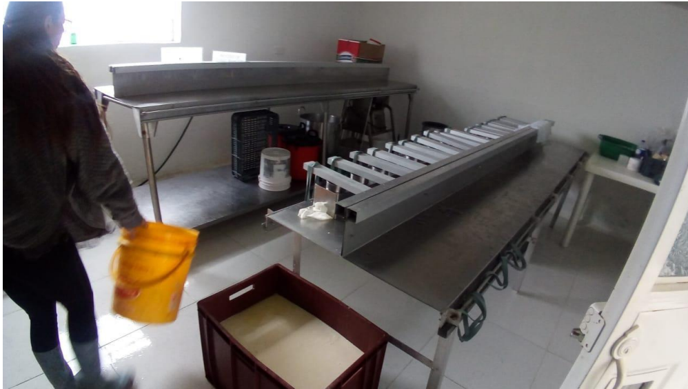
Planta de transformación de lácteos.
