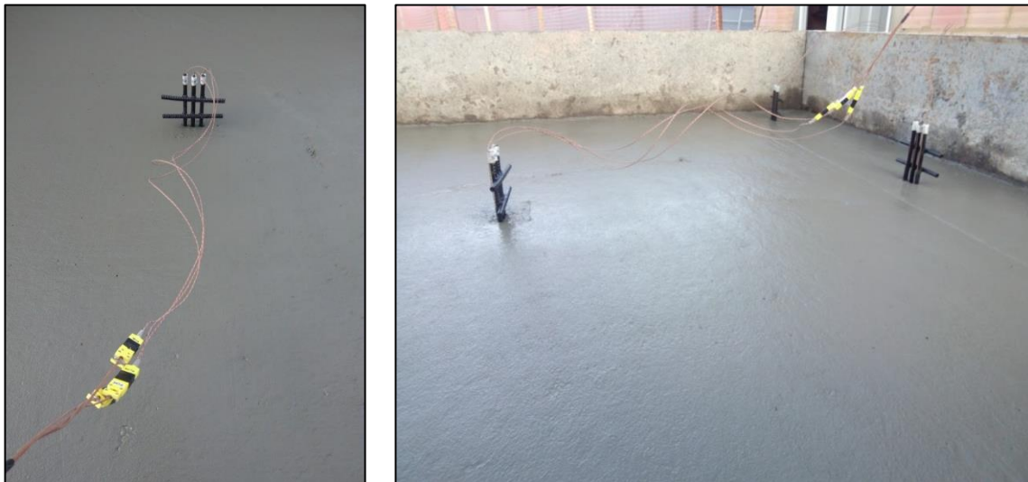
Fig. 19. Instalación de termocuplas en placas
