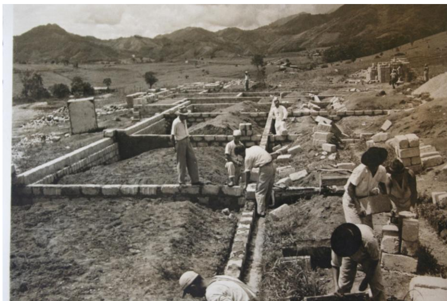
Foto 8: Construcción del colegio La Salle, 1952 (ACGMCR)
