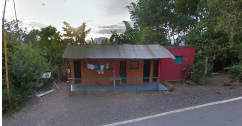
Vivienda en el casco Urbano sector sur con Cultivos en la zona trasera de la estructura
