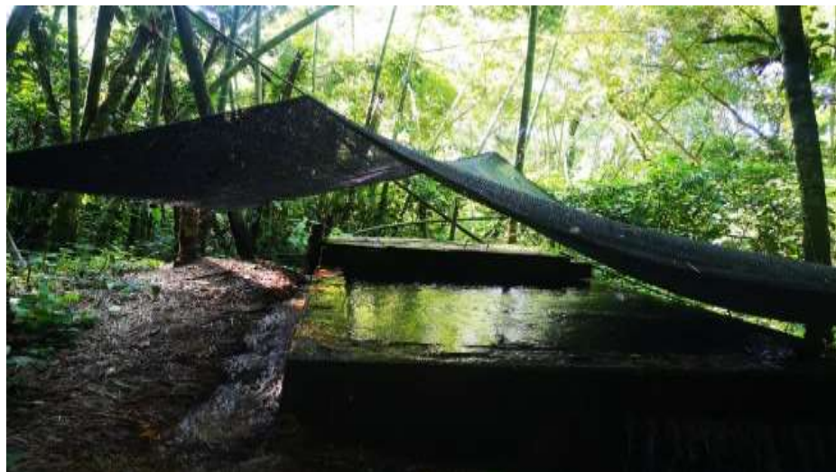
Figura 2. Tanque desarenador utilizado por la comunidad como tratamiento único del agua que se consume. Fuente Deyci Rodriguez 2021
