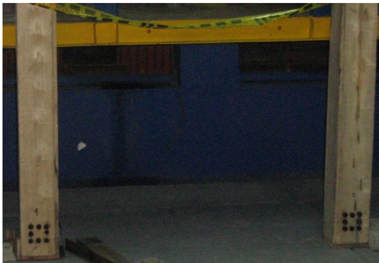
Imagen 5.12. Estructura plomada y nivelada
