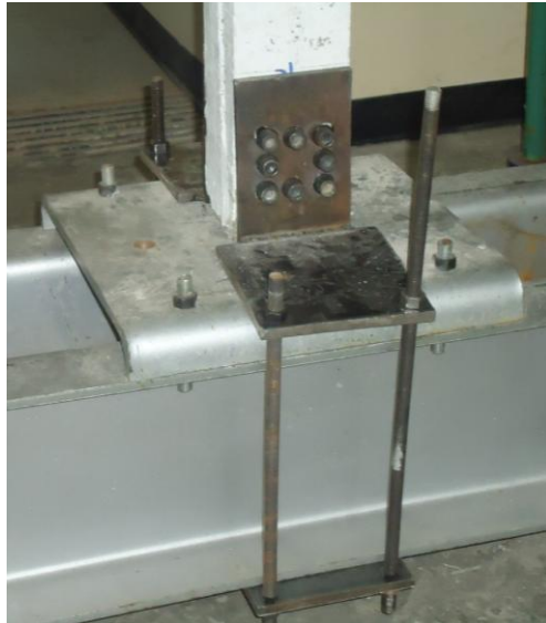
Imagen 5.19. Montaje del sistema de apoyos
