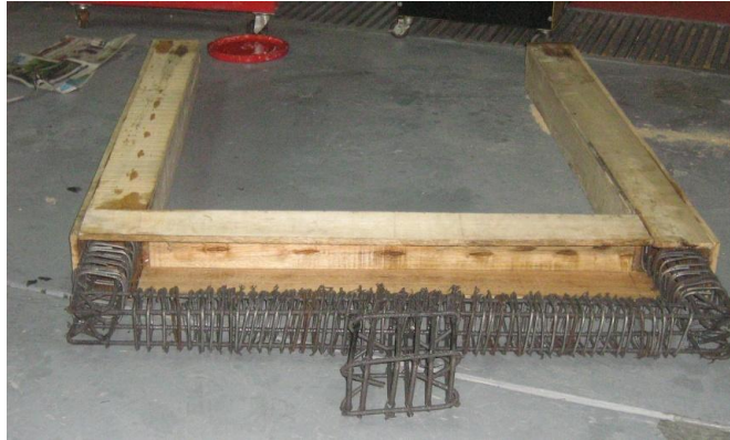
Imagen 5.11. Canasta de acero dentro de la formaleta
