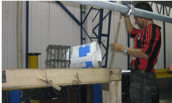
Imagen 5.13. Proceso de fundición del pórtico
