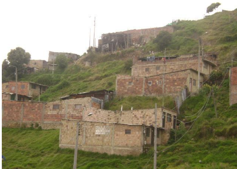
Fotografía 4. Vivienda del barrio San Martín parte baja. Fuente: Andrea Mejía. Junio de 2009.
