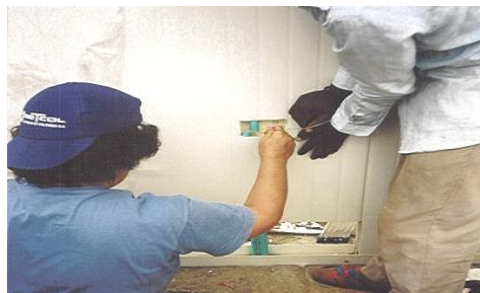
Foto 3.7. Montaje de instalación eléctrica incrustada en el panel 2
