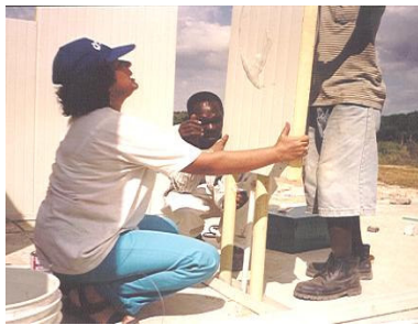
Foto 3.4. Instalación del primer panel de fachada 2
