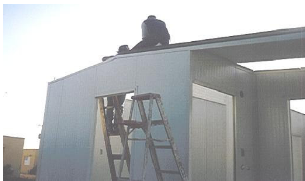
Foto 3.8. Instalación paneles de cubierta 1
