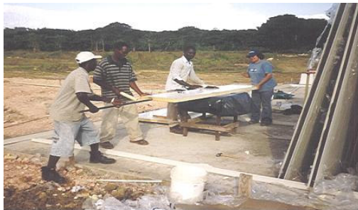
Foto 3.5. Preparación de páneces de fachada 1
