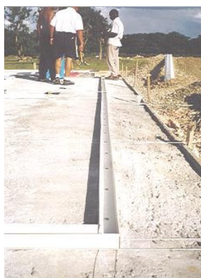
Foto 3.2. Instalación del accesorio de remate en “U” 2
