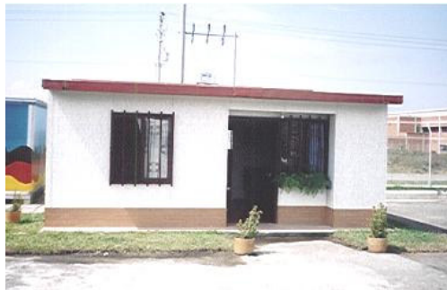
Foto 3.10. Vista frontal de la casa terminada 2
