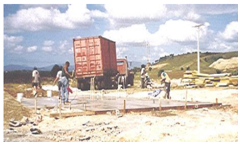
Foto 3.1. Fundición de placa de cimentación e instalaciones 1
