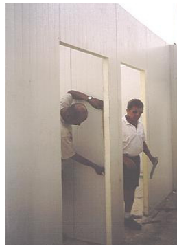
Foto 3.6. Vista interior de la vivienda durante la construcción 2
