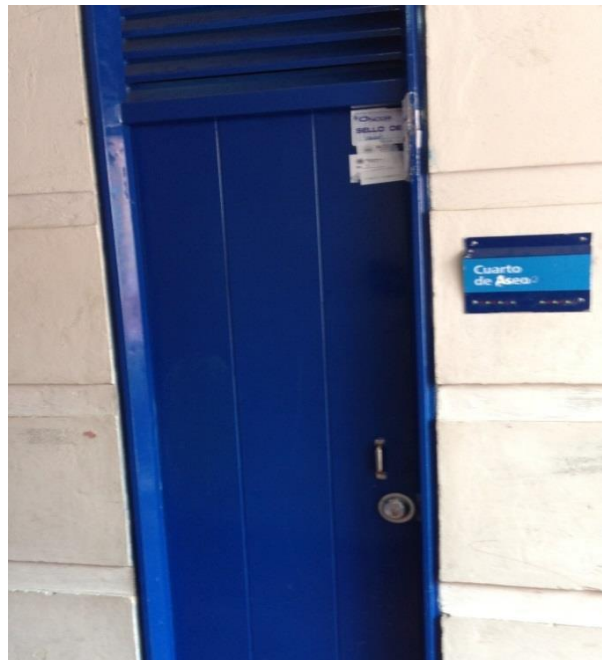
Figura 7. Cuarto de aseo del colegio
