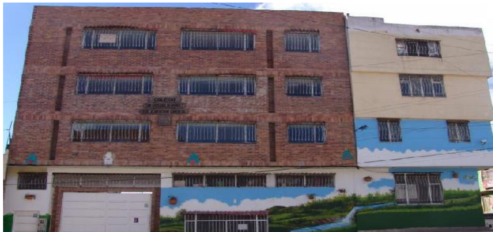
Figura 2. Fachada Colegio Técnico Agroalimentario Comercial San Gregorio Hernández
