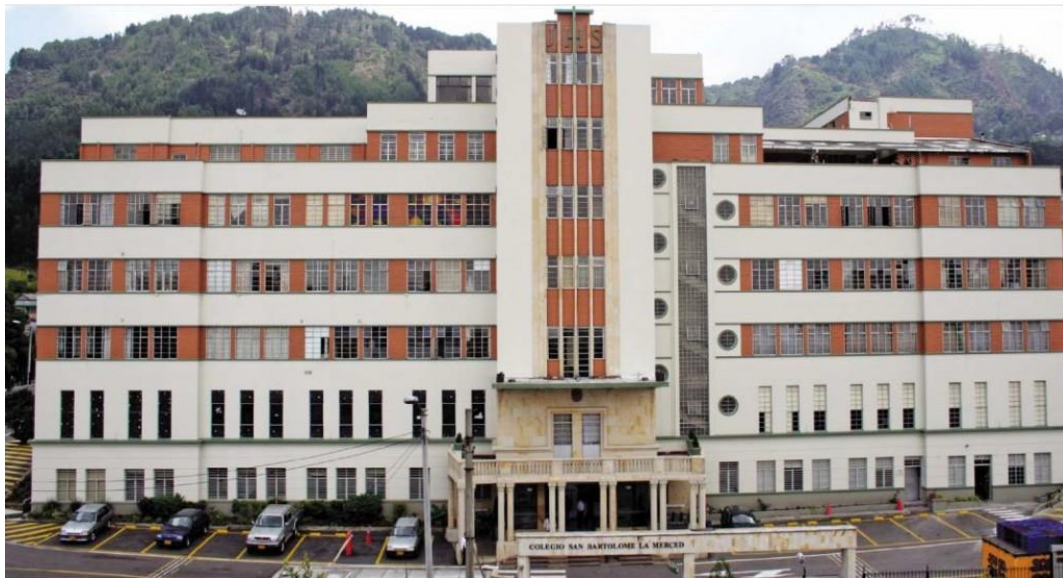
Figura 3. Fachada Colegio San Bartolomé la Merced. Tomado de (Federación Latinoamericana de Colegios Jesuitas e Ignacianos, 2013)
