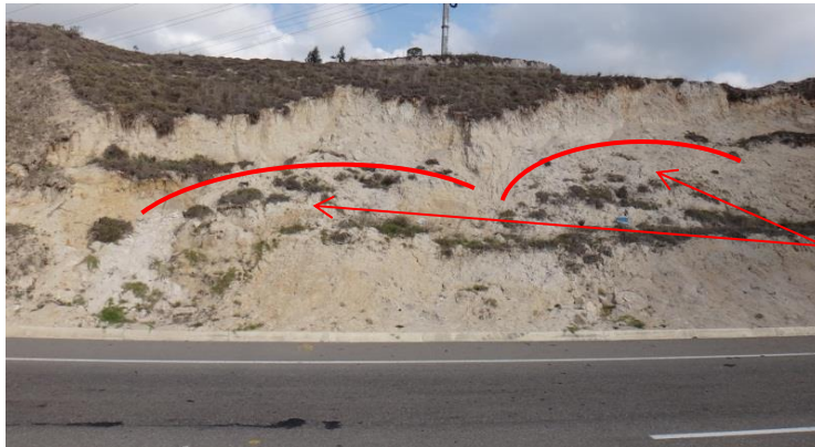
Fotografía 4. Reconocimiento de las fallas presentes en el Talud
