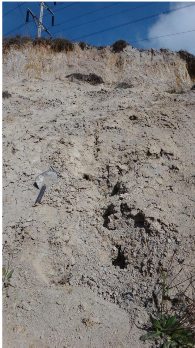
Fotografía 7. Vista frontal del talud
