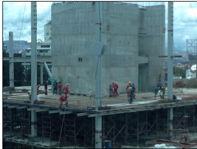
Figura 20. Fotografía de colocación de acero de refuerzo y acero de tensionamiento.
