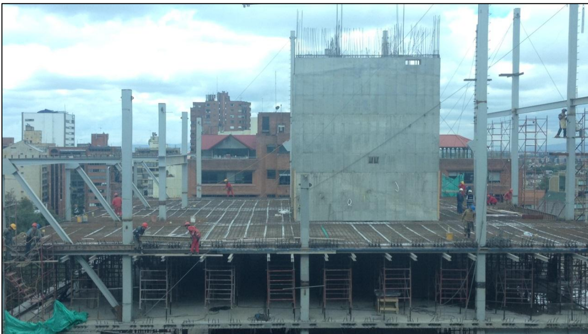
Figura 17. Fotografía obtenida manualmente desde el edificio Fernando Barón S.J
