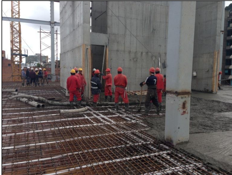
Figura 33. Obreros a la espera de la llegada del concreto.
