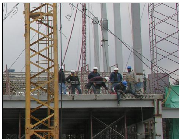
Figura 23. Fotografía del proceso de tensionamiento de los cables.
