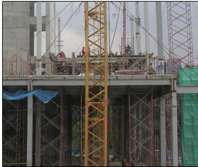
Figura 19. Fotografía de la colocación de cimbra y camillas de la losa.
