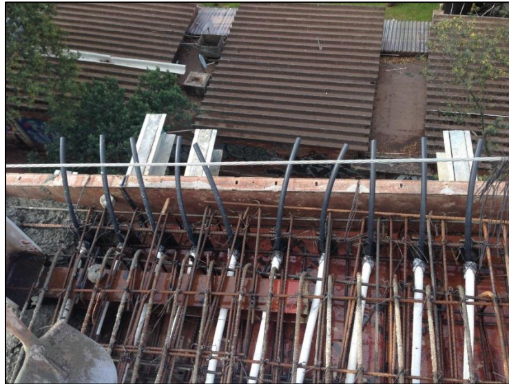
Figura 24. Fotografía de las mangueras por las cuales se inyecta la lechada.
