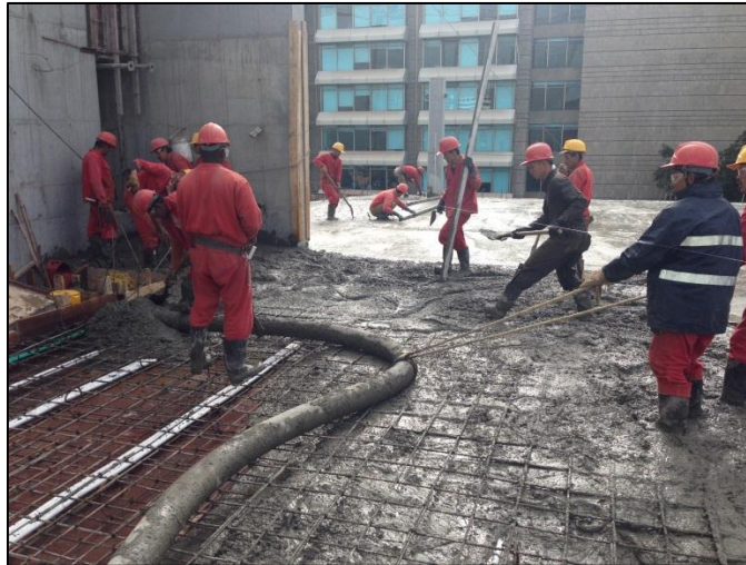
Figura 22. Fotografía del proceso de vaciado del concreto.
