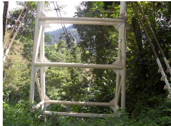
Imagen 2.10 Gasoducto Gibraltar. Foto suministrada por Beltrán F.E
