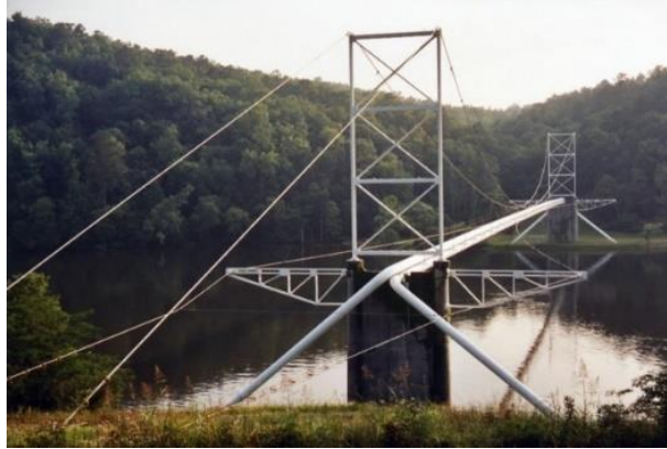
Imagen 2.3 Paso aéreo que transporta gas, ubicado en Clanton Vicinity, Alabama. Tomado de O'Donnell, P. (1990)
