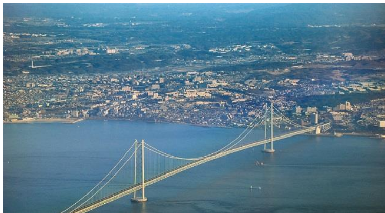
Imagen 2.1 Gran Puente Del Estrecho de Akashi Kaikyo, Japón. Tomado de Rötzel K. (2005)
