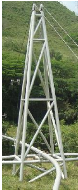
Imagen 4.6 Configuración de torre con elementos verticales inclinados. Foto suministrada por Beltrán F.E
