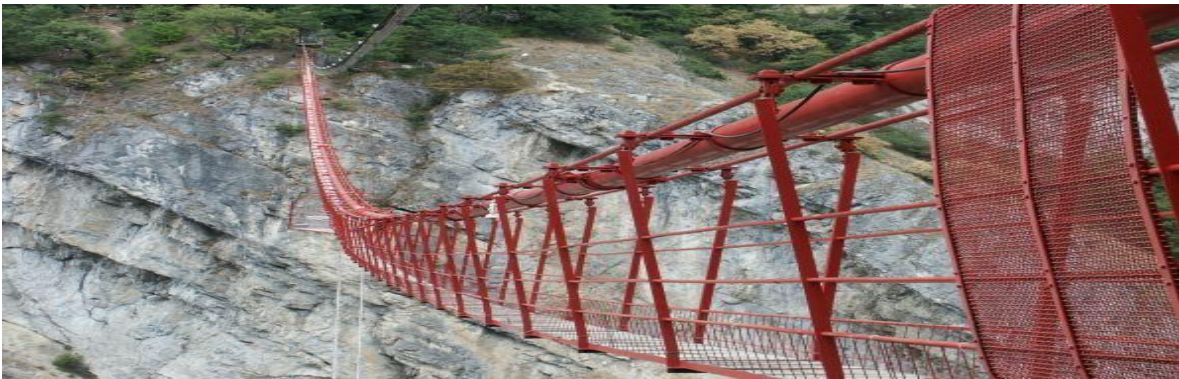
Imagen 2.2 Pont suspendu de l'araignée, Suiza. Tomado de StructuraE (2010)
