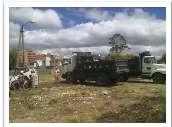
Cargue de material vegetal (Césped) para reuso en otros frentes de obra
