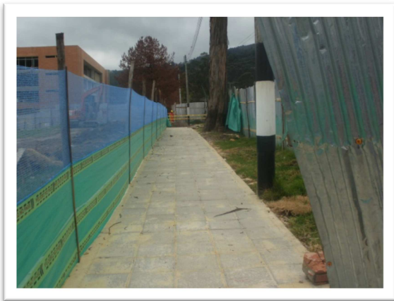
Senderos peatonales conformados con losas reutilizadas
