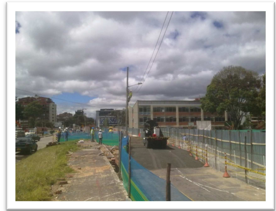
Reutilización de fresado del pavimento asfáltico
