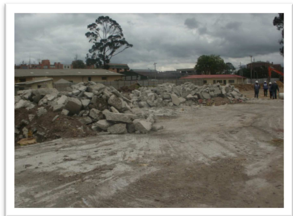
Áreas de ubicación de RCD aprovechables dentro de la misma obra para su posterior utilización
