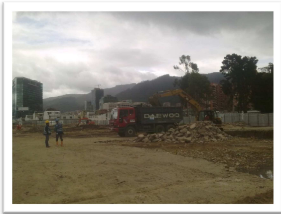
Separación de material proveniente de actividades de demolición
