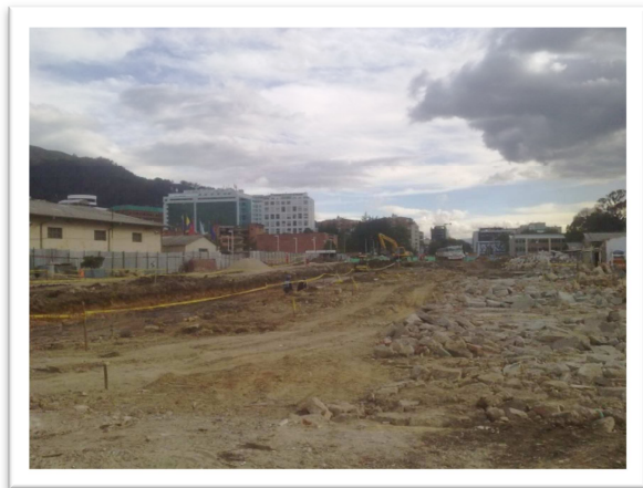
Empleo de Concreto Hidráulico reciclado como material de subbase del perfil vial
