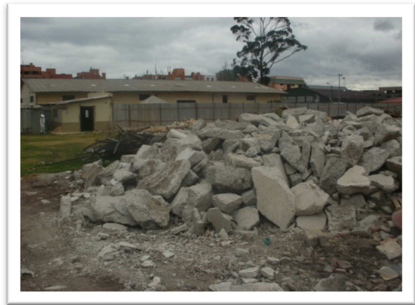
Separación en la fuente de metales y concreto hidráulico para usos diferenciales
