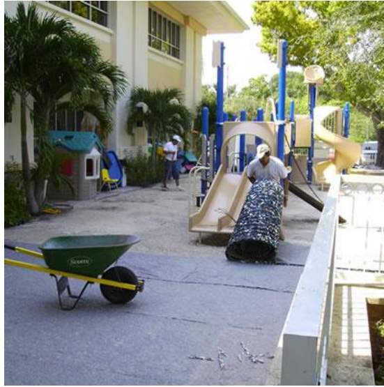
Ilustración 3 Instalación del espumado (Recycled Foam Technologies, 2008)
