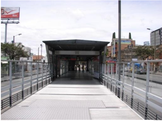
Interior estaciones sencillas – Calle 39
