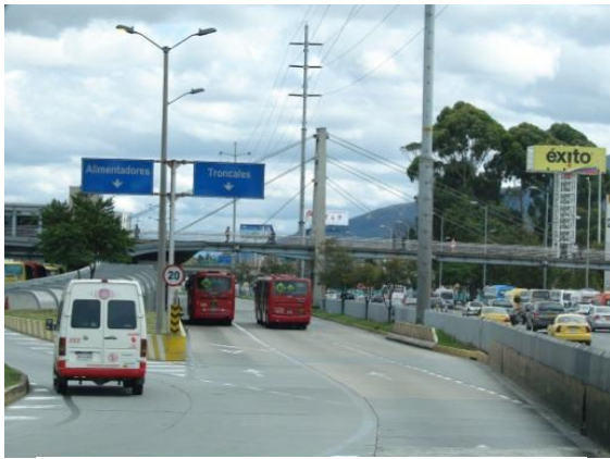
Acceso a estaciones de cabecera – Portal Norte
