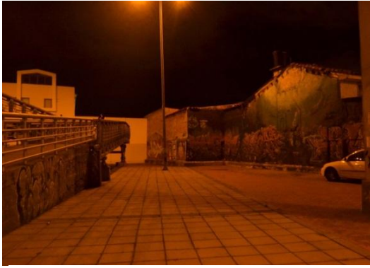
Adecuación de culatas y espacios públicos encerrados que generan inseguridad
