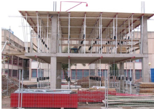
Figura 7. Proceso de cimbrado, clareado y descimbrado
