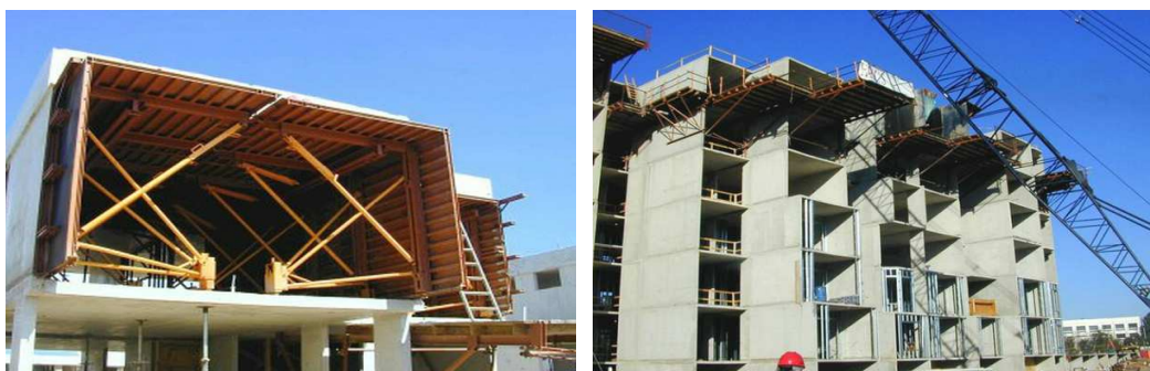
Figura 4. Sistemas tipo túnel.
