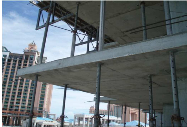
Figura 6. Proceso de cimbrado y descimbrado
