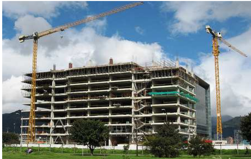
Figura 5. Proceso de cimbrado y descimbrado.
