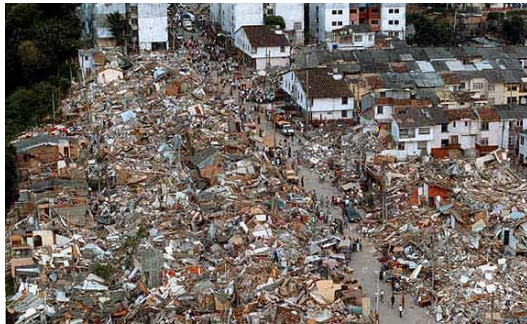
Fig 5. Casas colapsadas después de terremoto
