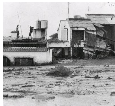
Fig 11. Casas cubiertas por escombros
