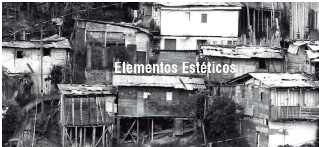
Imagen 1, Vivienda Campesina Cafetera Pereira
