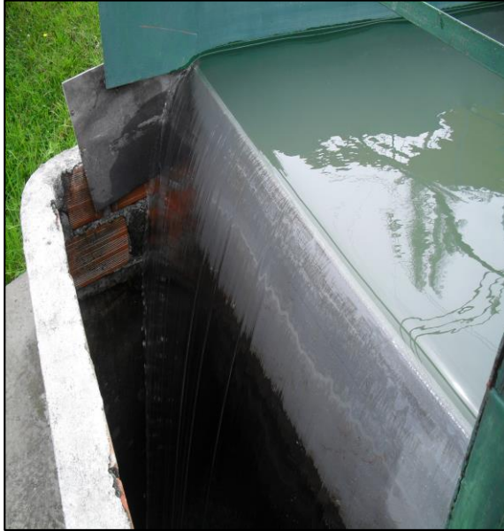
Figura 29. Vertedero rectangular suprimido Fuente: (INGETEC S.A, 2011)
