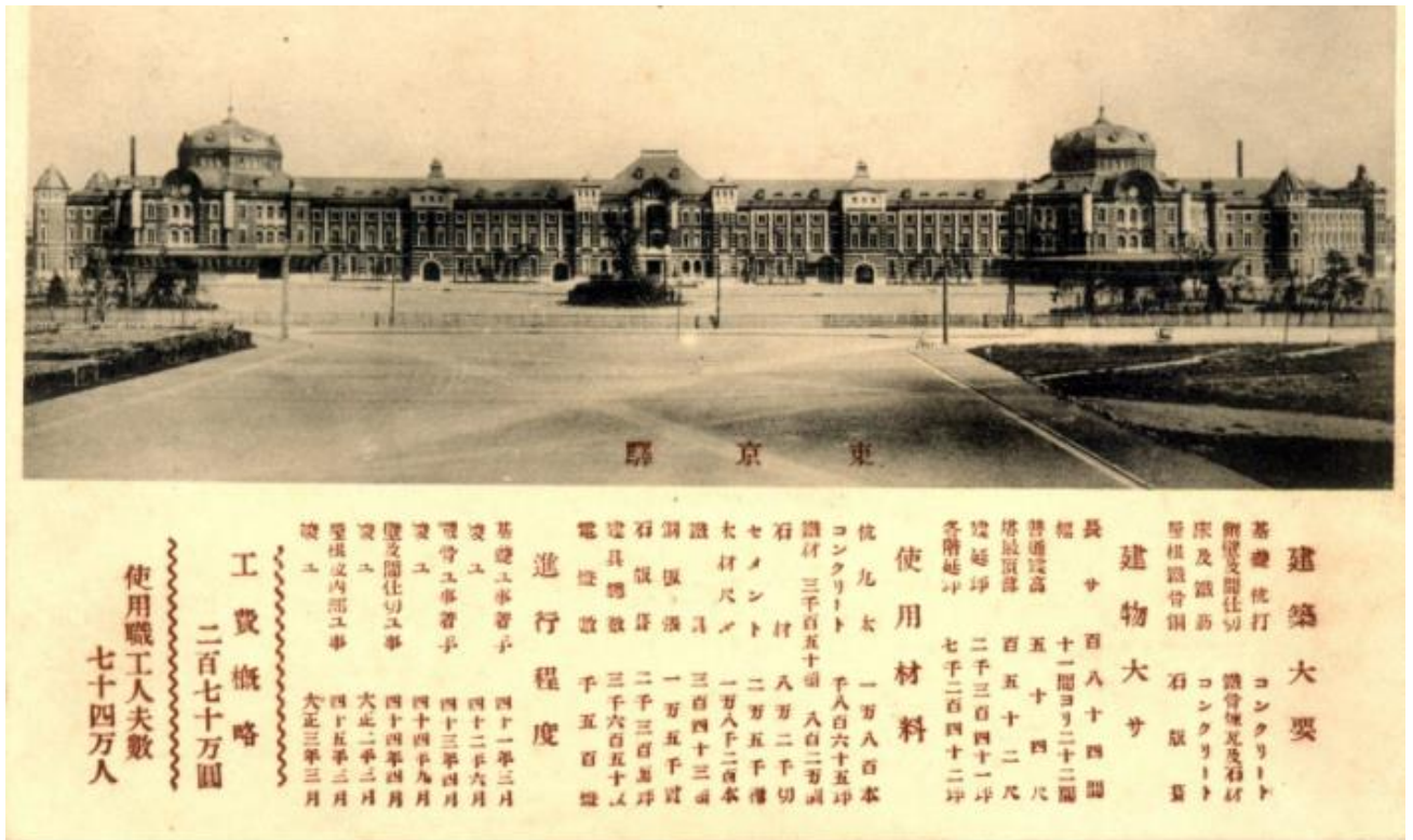
Ilustración 24 Estación de Tokio poco después de su inauguración. Abajo se detallan los materiales de construcción.
