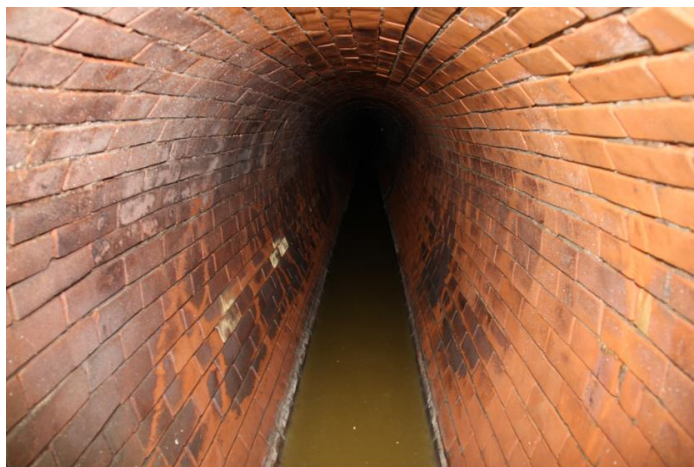
Ilustración 34 Alcantarilla ubicada en Kanda
