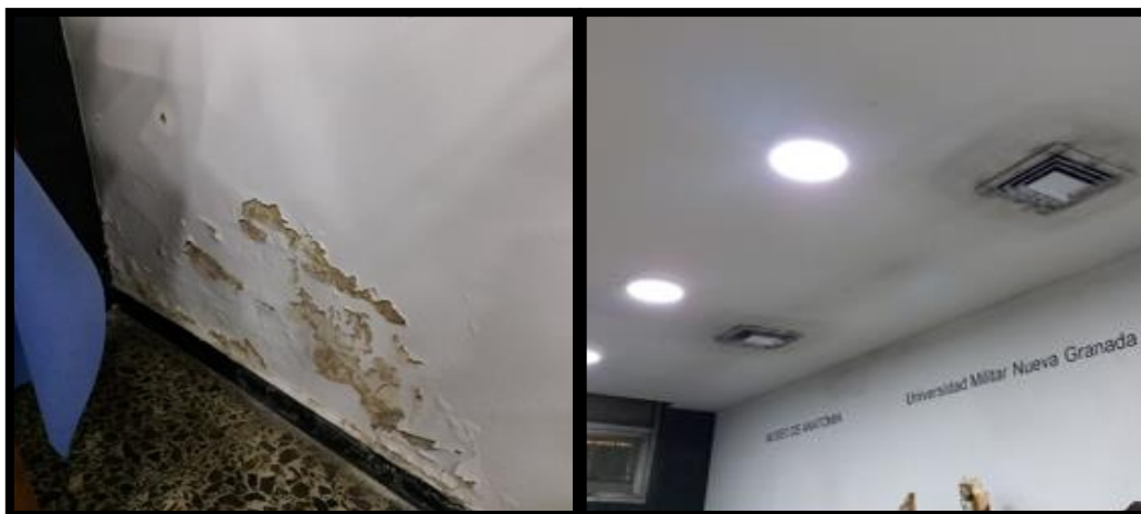
Figura 3. Humedad y condición de la ventilación en el Museo de Anatomía de la Universidad Militar Nueva Granada.
