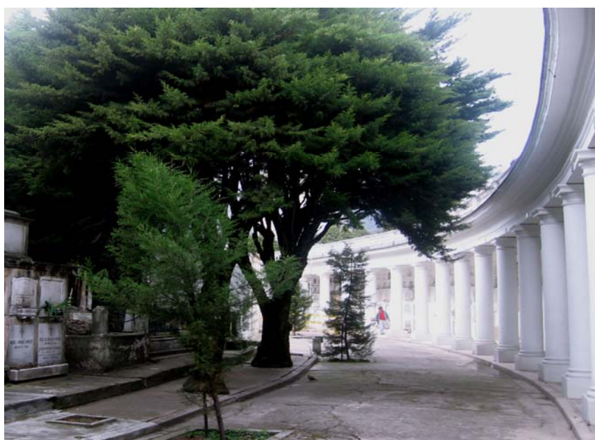
Foto 1. Bóvedas sector Elipse. Muro límite con el Trapecio.
