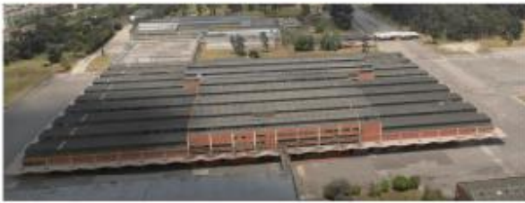
Bodega Norte Actual Imagen tomada de Google Earth por medio de Street View
