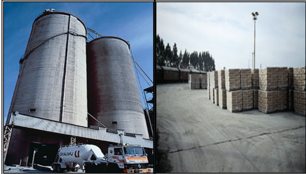
Figura 7. Almacenamiento del Cemento
