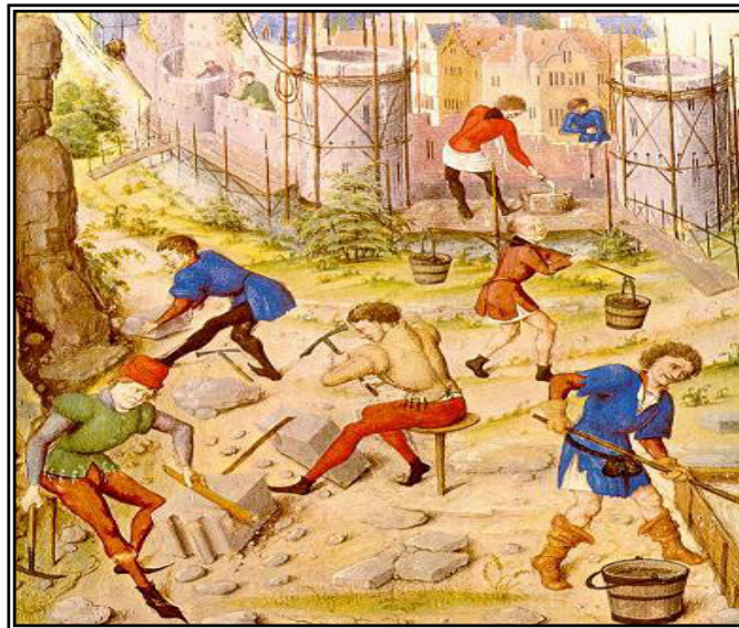
Figura 11. Trabajadores construcción de 1935
