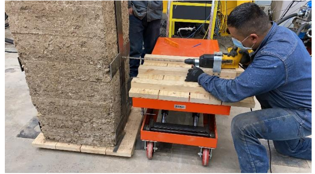
Figura 21 - Perforaciones en muros de tapia pisada
