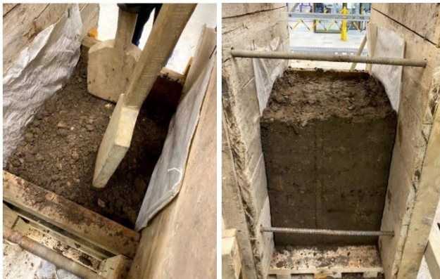
Figura 20 - Compactación de capas de tierra para muros
