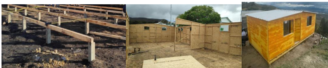
Imagen 2: En la foto de la izquierda se evidencia la puesta de pilotes y las vigas de piso, en la foto de la mitad se evidencia la puesta de pisos y el ensamblaje de los paneles de madera y en la última foto se evidencia la vivienda completa pintada, con techo, ventanas y puerta (Fotos mías tomadas en 2022)
