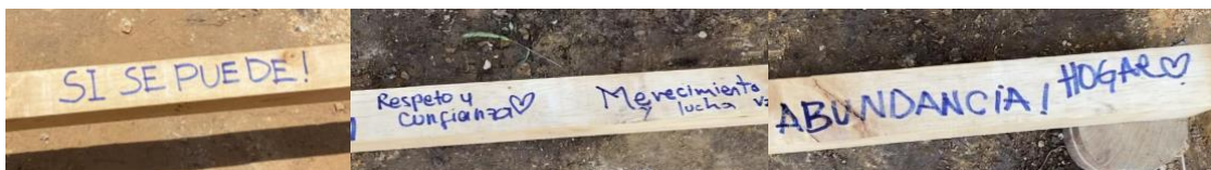
Imagen 3: En la foto de la izquierda sobre la viga de piso un voluntario escribe ¡SI SE PUEDE!, en la segunda imagen sobre la misma viga de piso unos voluntarios escriben “Respeto y confianza”, “Merecimiento y lucha”, en la foto de la derecha se escribe “Abundancia y hogar” (Fotos mías tomadas el 20/08/2022).
