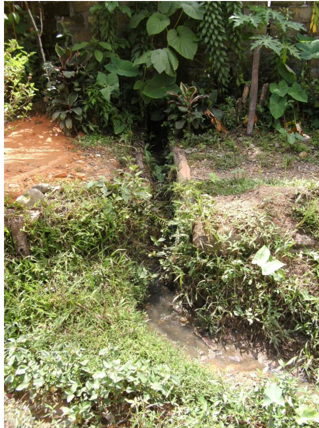
Foto 9: Canal abierto de aguas residuales. Municipio de Atrato.
