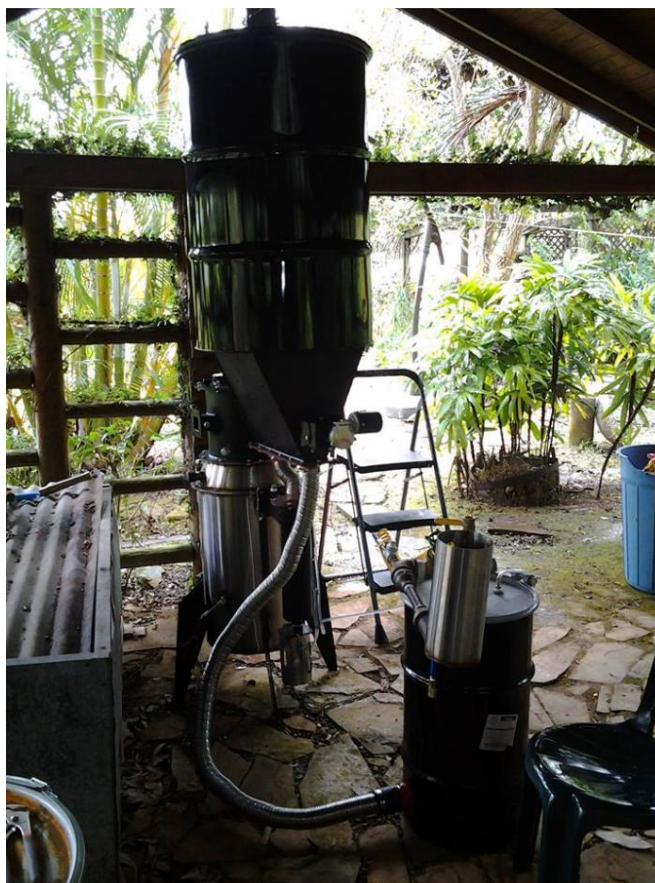
Ilustración 26: Planta GEK instalada. Fuente: ALL POWER LABS (Labs A. P., 2014)
