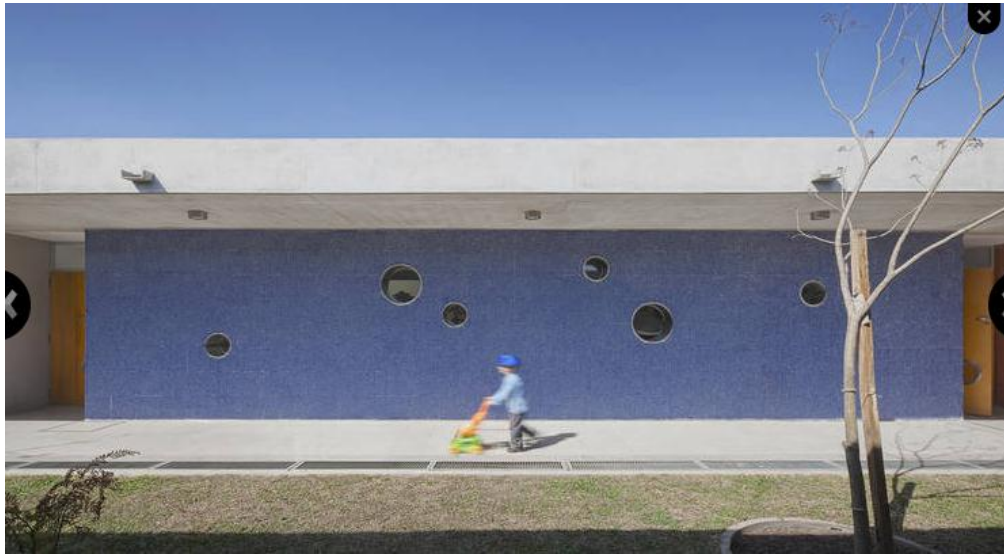
Galerías perimetrales de circulación.
